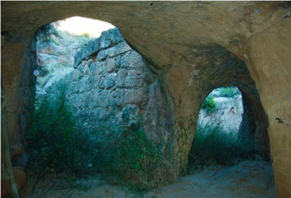
Situación de uno de los aliviaderos al interior.
