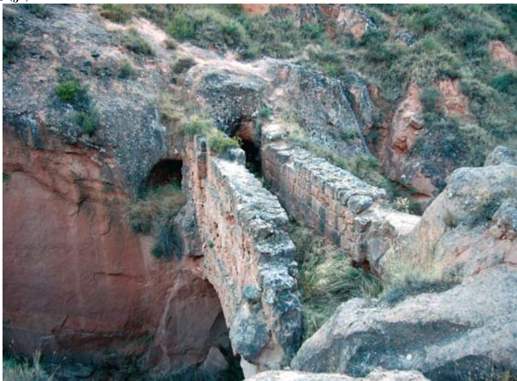
Situación de uno de los aliviaderos al exterior.
