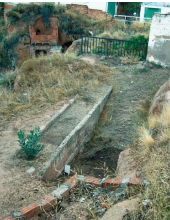
Canalización de cemento del “proyecto Carvajal”, años 20 del siglo XX. Zona de la Fuente de Santiago. Estado actual.
