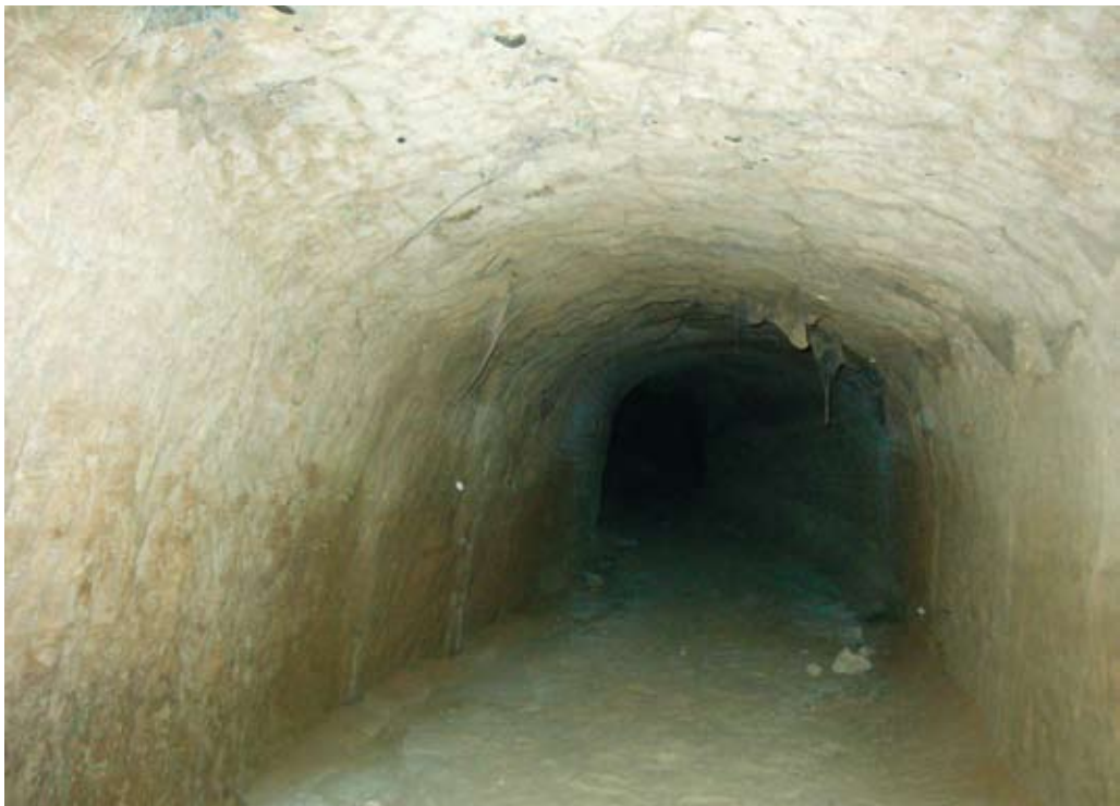
Interior de uno de los túneles.
